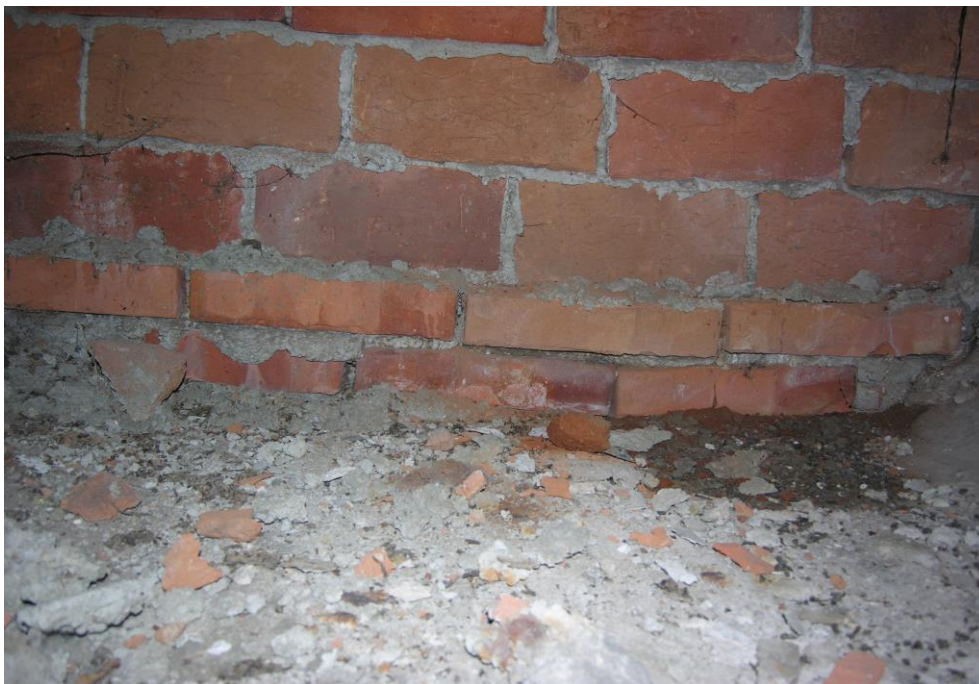
Obr.C37-895 Sonda B do spáry mezi 8. a 9. nosníkem 3. pole, 1,5 až 2,0 m za lícem úložného prahu 3. podpěry, - pohled k bednění podporového příčnicku vyzděného z cihel, - dole opadané trosky krycí vrstvy podhledu horní spáry, - vpravo stopa po zatékání do dutiny mezi nosníky přes podporový příčník.
