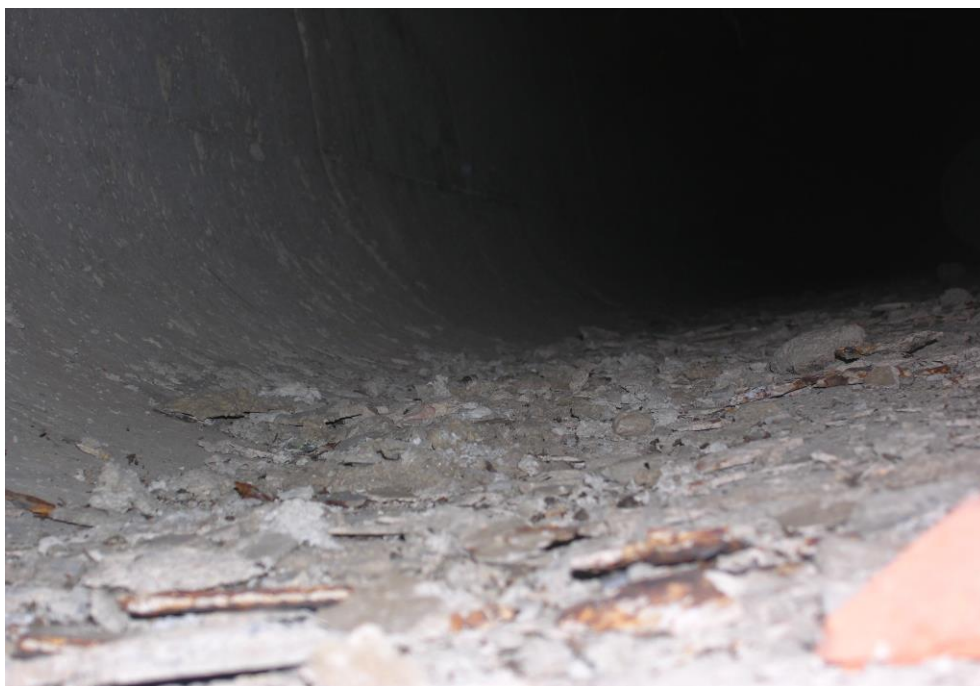
Obr.C37-909 Sonda B do spáry mezi 8. a 9. nosníkem 3. pole, 1,5 až 2,0 m za lícem úložného prahu 3. podpěry, viz obr.C37-901, detail opadaných krycích vrstev
