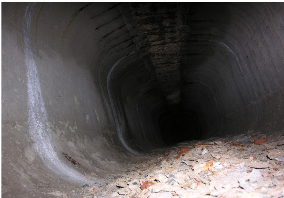
Obr.C37-887 Sonda A do spáry mezi 3. a 4. nosníkem 3. pole, 1,5 až 2,0 m za lícem úložného prahu 3. podpěry,
