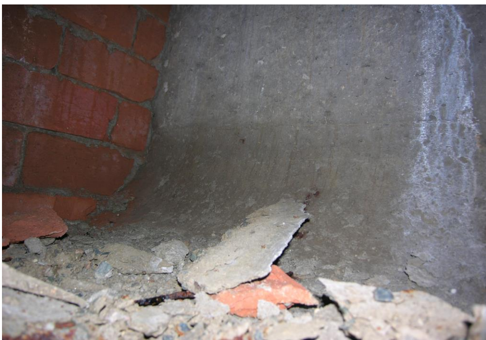
Obr.C 37- 868 Sonda A do spáry mezi 3. a 4. nos- níkem 3. pole, 1,5 až 2,0 m za lícem úlož-
