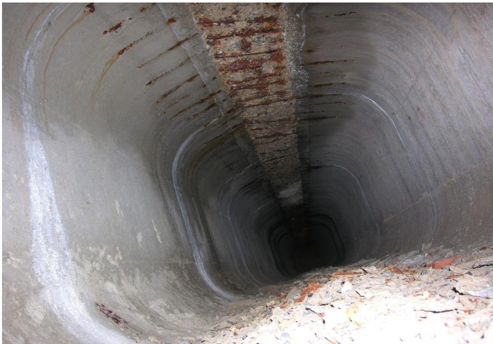
Obr.C37-886 Sonda A do spáry mezi 3. a 4. nosníkem 3. pole, 1,5 až 2,0 m za lícem úložného prahu 3. podpěry,
