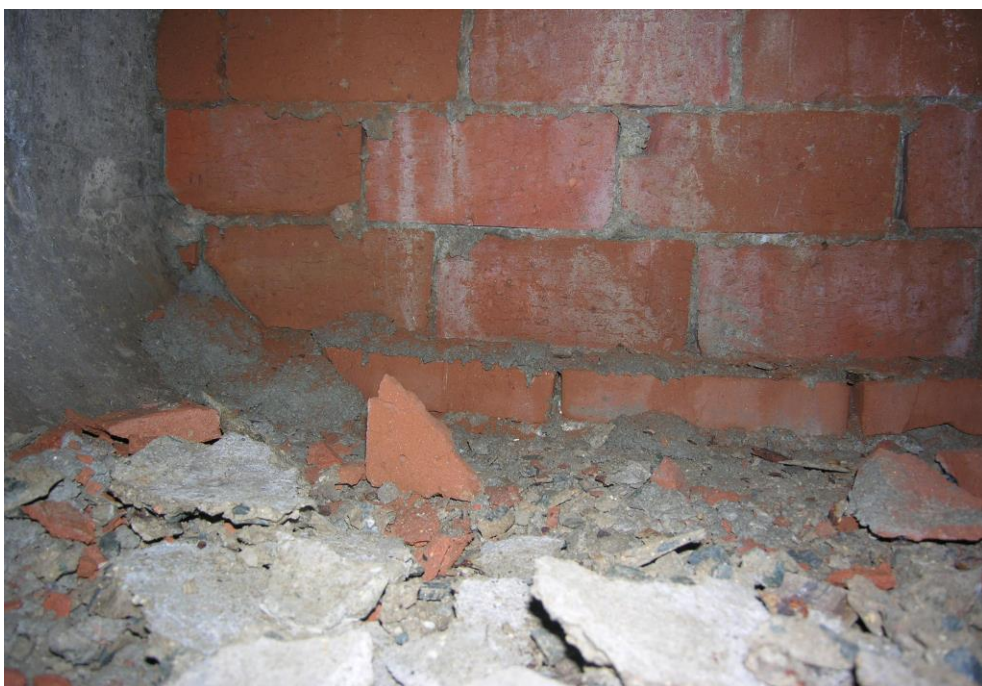
Obr.C37-890 Sonda A do spáry mezi 3. a 4. nosníkem 3. pole, 1,5 až 2,0 m za lícem úložného prahu 3. podpěry,
